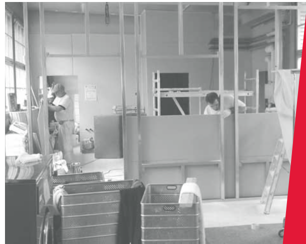
Im Zuge der Übernahme wurden in den letzten Wochen grössere Umbauten im Gebäude der Weiss Wäscherei notwendig
